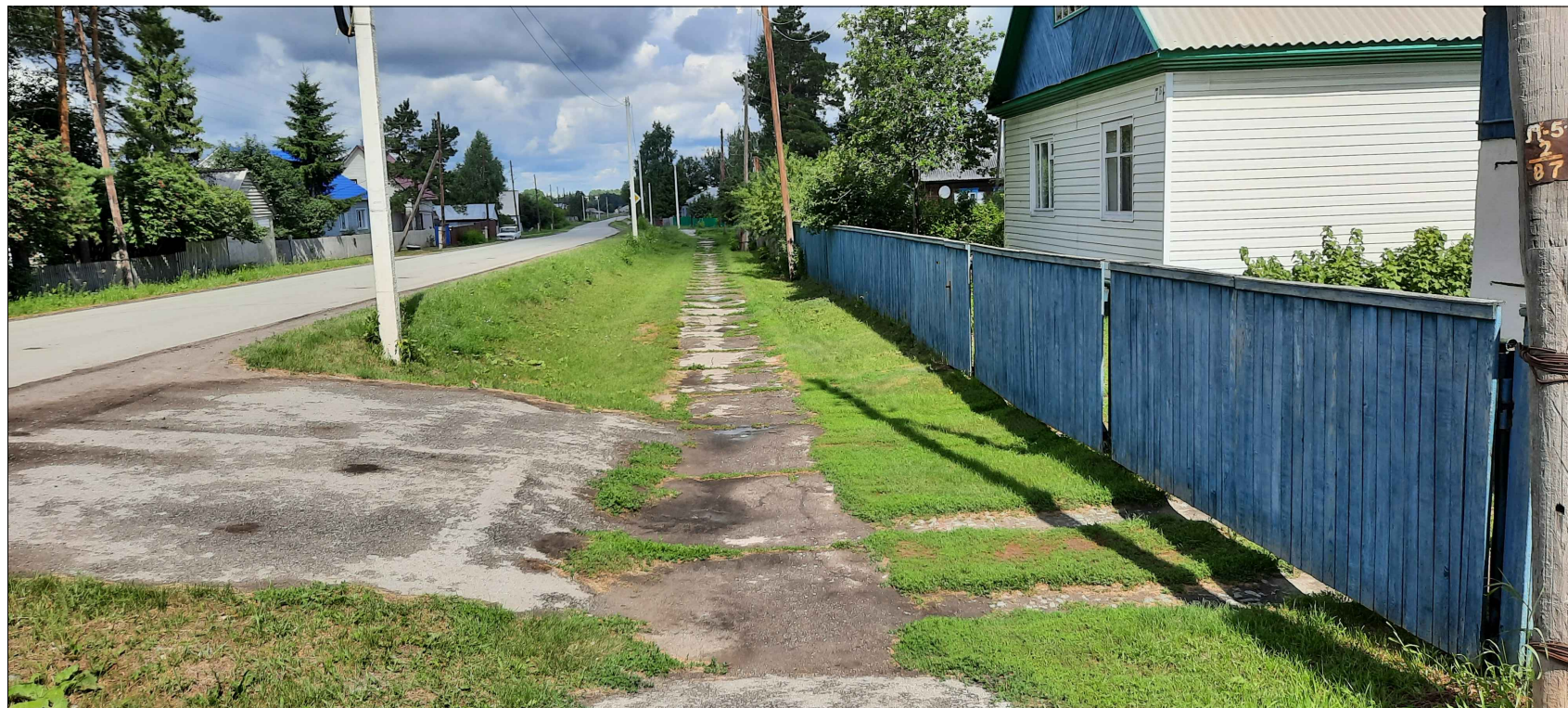
Пешеходная дорожка до благоустройства
